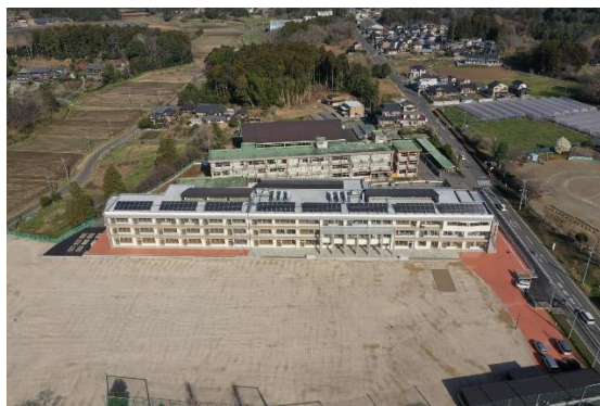
写真 12 玉里学園義務教育学校に設置された 太陽光発電設備
