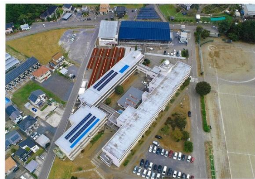
写真 13 市立美野里中学校に設置された 太陽光発電設備
