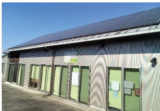
写真 10 屋根上太陽光（小美玉市部室）
