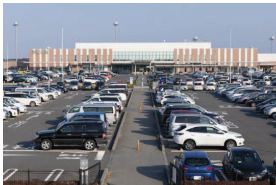
写真 38 茨城空港（外観）
