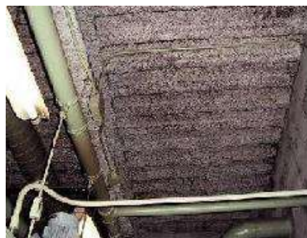
石綿含有スレート波板(屋根・外壁)
