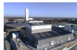
クリーンセンター（高崎地区）
