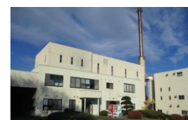
中継センター（堅倉地区）
