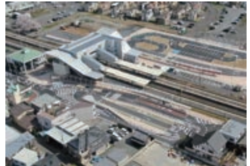
▲JR 羽鳥駅橋上駅舎と東西駅前広場
