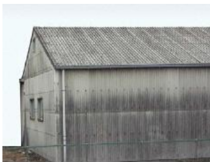
石綿含有吹付けロックウール
