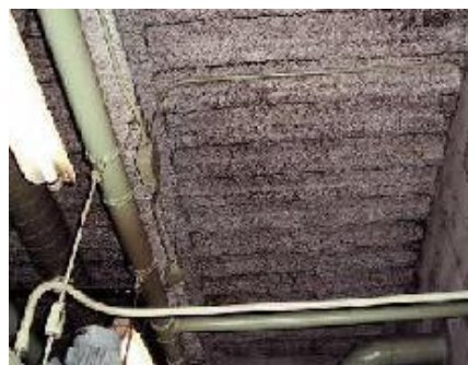
石綿含有スレート波板(屋根・外壁)
