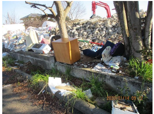
小川 私有地 残土・建築廃材
