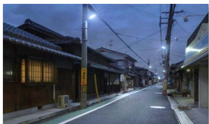
LED防犯灯（設置例）
