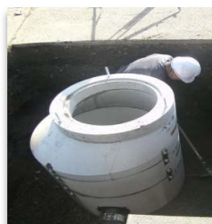
マンホール設置工事の様子
