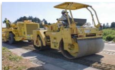
道路補修工事
