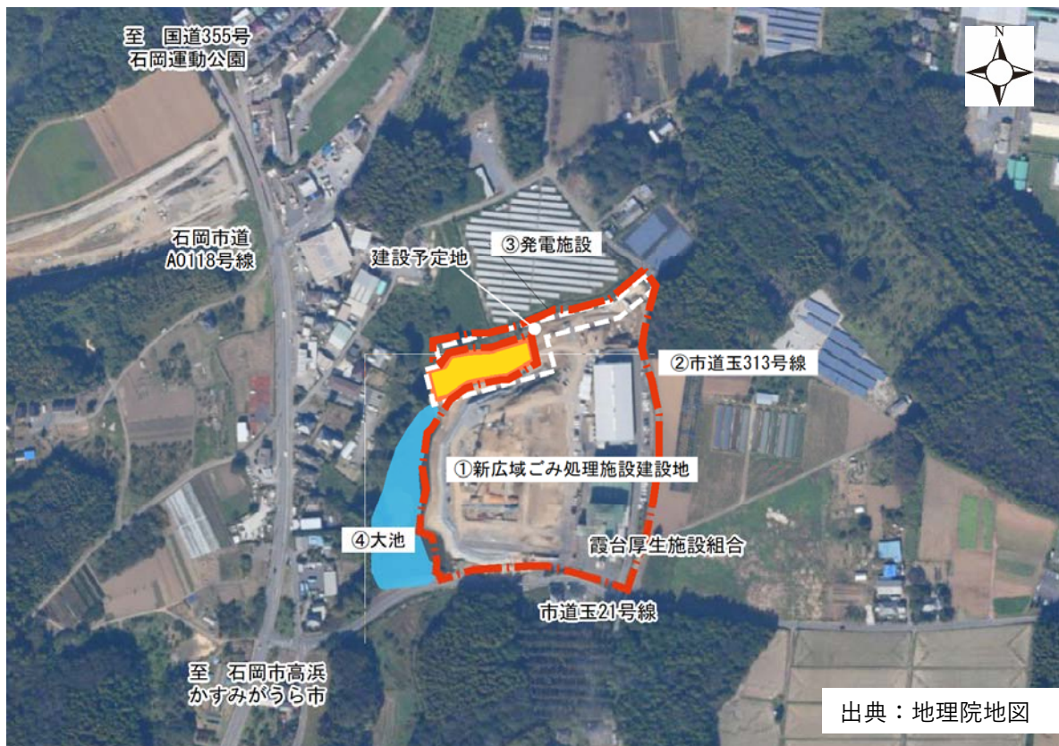
[図 2-1-3 建設予定地周辺の状況]
