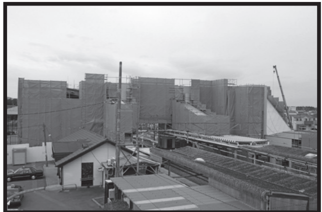
<新駅舎工事中（4月12日現在）>
